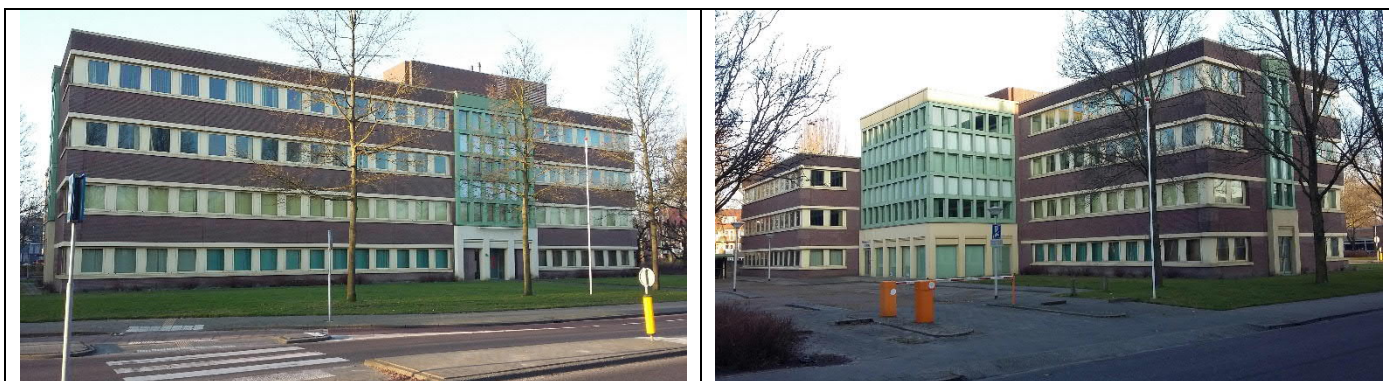
Aanzicht van het kantoorpand aan de voorzijde (links) en achterzijde (rechts)
